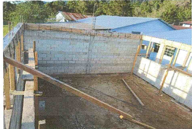
Foto 4: Fundición de solera de ventanas en la estructura.
