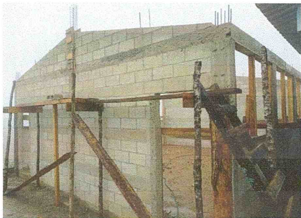
Foto1: Vista lateral de la estructura.
