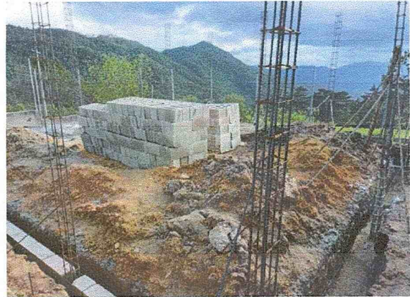
Foto 2: Realización del sanjeo y pega de block.
