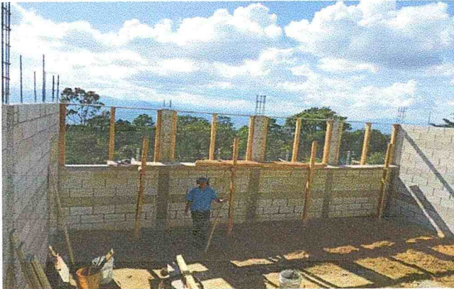
Foto 3: Pega de block llegando a la mitad de la estructura.
