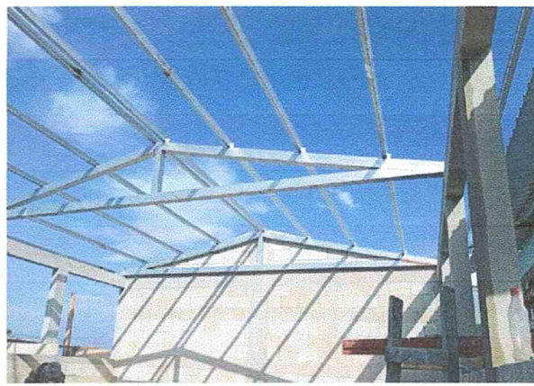
Foto 2: Colocación de costaneras del entechado de la estructura.
