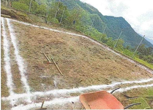
Foto1: Marcaje del área a trabajar la estructura.
